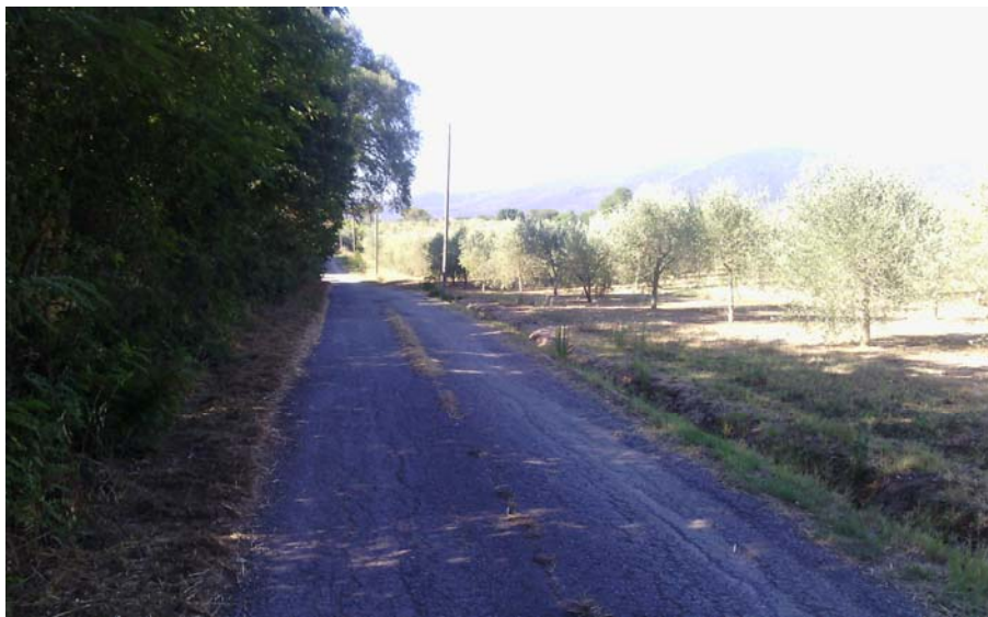
Foto 2.7.1: vista generale dell'area – intervento 7
