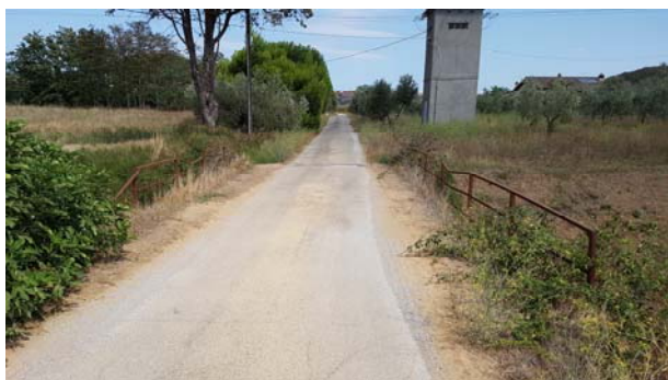
Foto 2.9.1: vista generale dell'area – intervento 9
