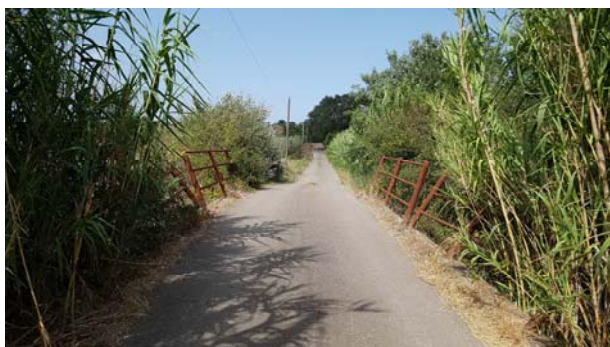
Foto 2.8.1: vista generale dell'area – intervento 8
